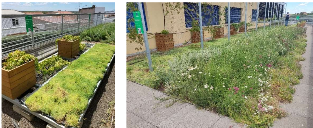
Figura 1. Instalación de los prototipos de cubierta verde en el CEIP Gabriela Mistral
